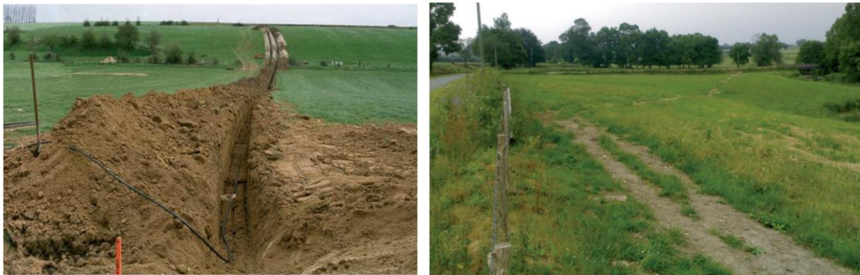
Photo : Exemple de tranchée ouverte et de tranchée fermée depuis 2 mois (Source : Ora environnement)
